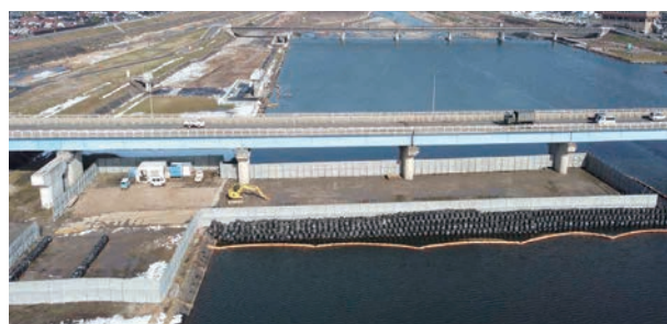
仮囲い(目隠しフェンス)設置状況
