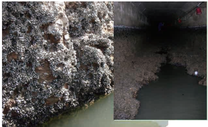
大塩貯水池(群馬県富岡市)におけるカワヒバリガイの付着状況 (左:貯水池岸壁面、右:直下の導水路内)
