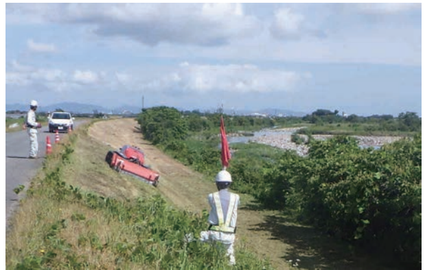
写真2 遠隔操縦式除草機による日野川堤防の除草作業
